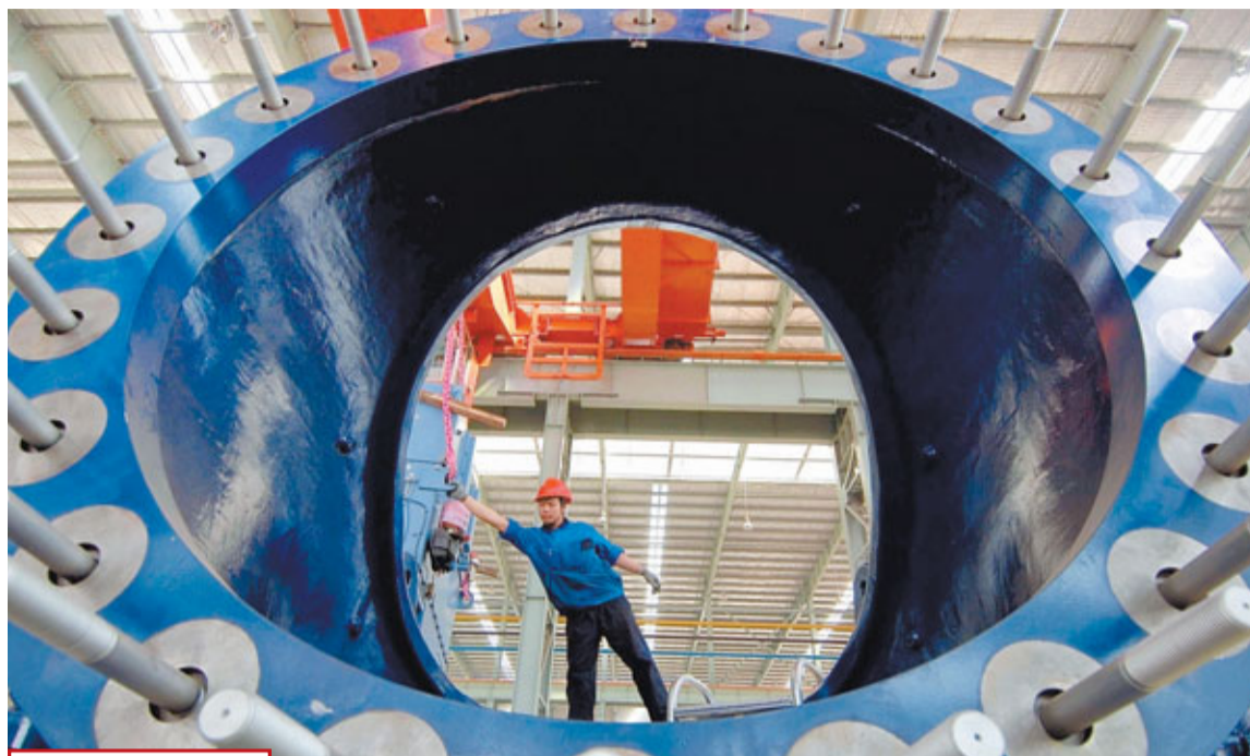
發展風能發電 山東省樂成市三面環海,風能資源豐富,至今已引進風電項目約25萬千瓦,累計完成發電量近6億度。圖為工人在組裝風電的發電機。
