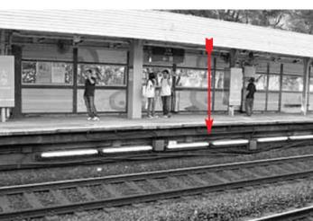
■大學站月台石屎外牆的接縫(剪嘴示)膠邊剝落,驟眼看來像一條裂縫。港鐵提供圖片
