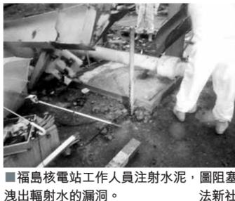
福島核電站工作人員注射水泥，圍阻洩出輻射水的漏洞。法新社
