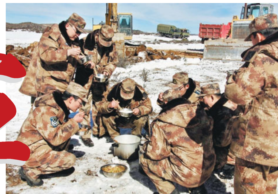
2010年12月8日，官兵們在稻城亞丁機場施工工地上風餐露宿。
