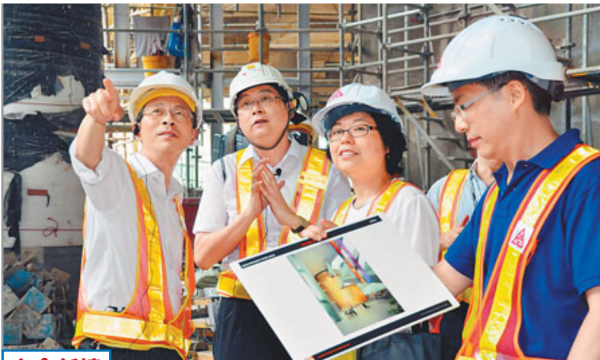
立會新樓 立法會行政管理委員會委員昨日到添馬艦的立法會綜合大樓工地視察,了解工程的最新進展。圖為立法會主席兼行管會主席曾鈺成(左)聽取承建商代表簡介立法會綜合大樓地下大堂的施工情況。
