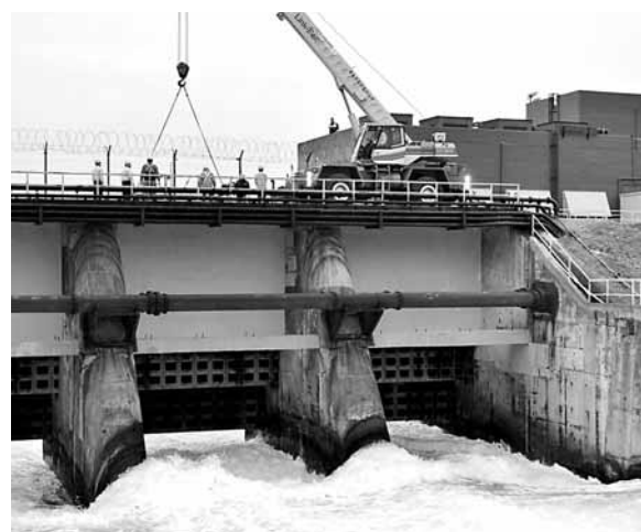
台電計劃在核二、三廠加設閘門防海嘯。圖為核一廠的防海嘯閘門。資料圖片
