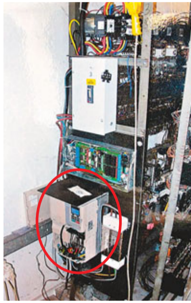
電腦控制調頻調壓控制系統(紅圈)安裝於升降機系統,可令升降機運作更暢順。香港文匯報記者 鄭佩琪 攝
