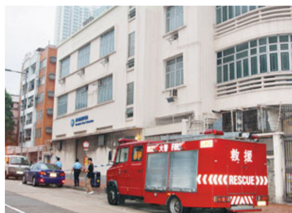
■發生爆炸的嘉林邊道電力變壓站。
