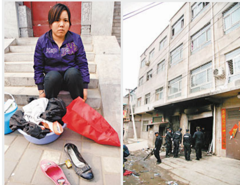
倖存者楊艷紅，逃出火場時在慌亂中穿了兩隻不同的鞋。失火建築完全沒有消防安全設計，二層以上的窗戶全部被金屬護欄封死。香港文匯報記者李茜婷攝
