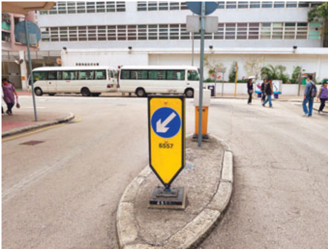
■路政署在九龍城盛德街試驗設有回彈功能的反光式安全島標柱。
