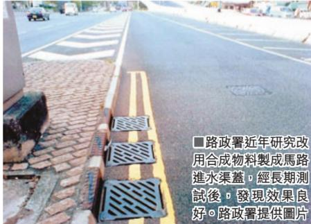
香港文匯報訊(記者 羅敬文)本港多年來的馬路進水渠蓋以生鐵鑄造,物料雖然堅固,但卻容易生銹。路政署近年研究改用合成物料製作渠蓋,經測試後發現不會生銹,成本相若;又因合成物料並非金屬,變質價值不高,減低渠蓋成為「偷鐵黨」獵物的機會。路政署表示,現已在道路維修合約中,接納使用合成物料製成的渠蓋。
