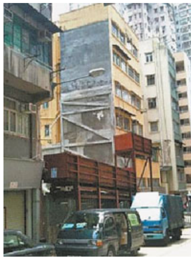
西營盤第二街110至118號唐樓已被收購。
