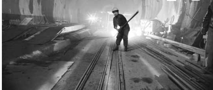
■京福高鐵安徽段工程全面鋪開。圖為13日，一名施工人員在北山隧道工程中作業。新華社
