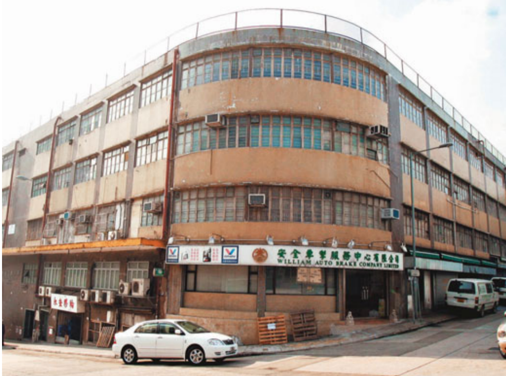
發展局接獲47宗改裝或重建舊工廈的申請，其中20宗已獲批，可釋出約8.2萬平方米的工業樓面面積作非工業用途。圖為油塘一幢工廈。
