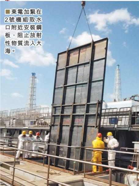
東電加緊在2號機組取水口附近安裝鋼板，阻止放射性物質流入大海。
