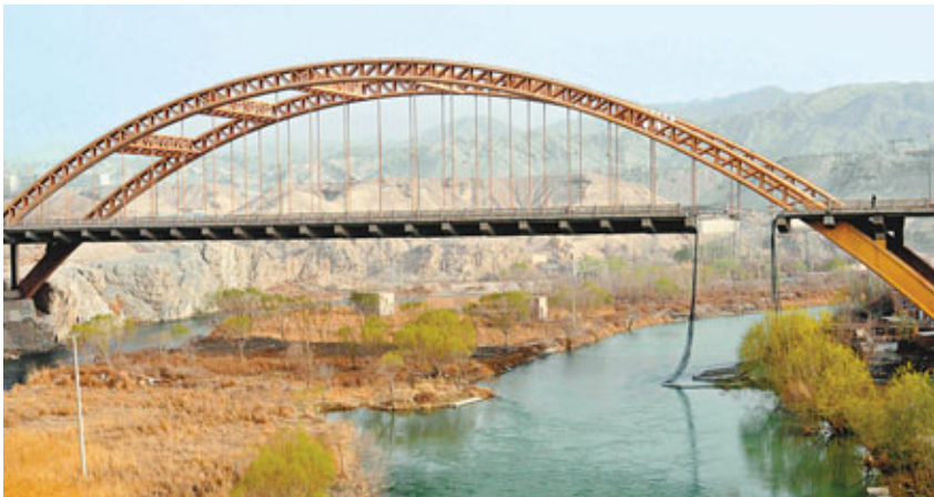
■新疆庫爾勒市孔雀河大橋垮塌現場。
