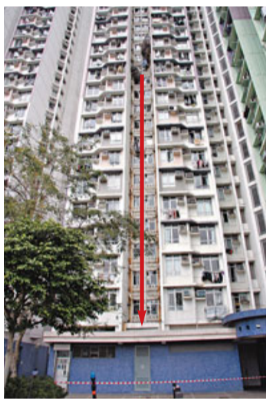
工人由14樓直墮一樓平台重傷。
