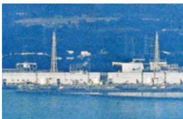
■核電站最新照片顯示，僅2號機組的外殼相對完整。美聯社
