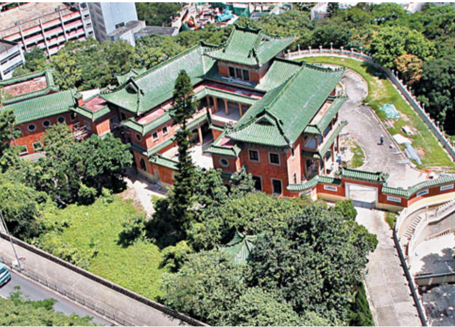
復修工程後，景賢里約80%已回復昔日原貌。發展局提供圖片
