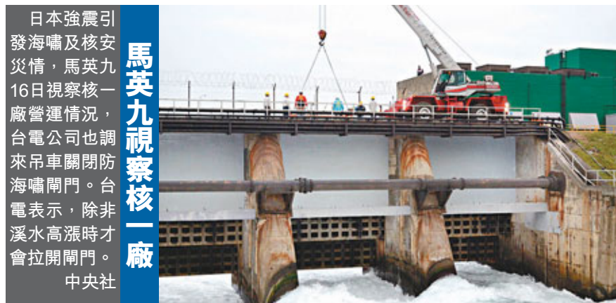
日本強震引發海嘯及核安災情，馬英九16日視察核一廠營運情況，台電公司也調來吊車關閉防海嘯閘門。台電表示，除非溪水高漲時才會拉開閘門。中央社
