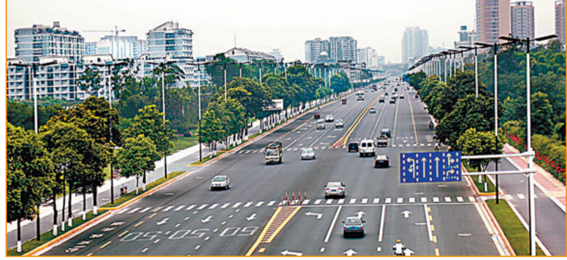
■改造完工的龍泉驛區(成都經濟開發區)北幹道
