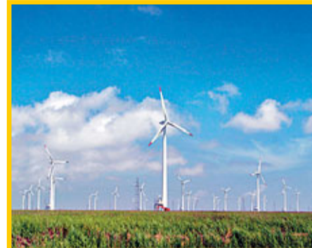
中電國際大豐風力發電有限公司
