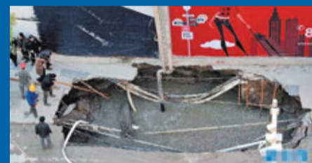
工作人員在探測塌洞的灌漿填充進度。
