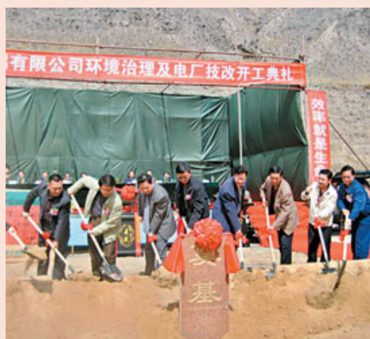
環鵬公司電廠技改工程開工
