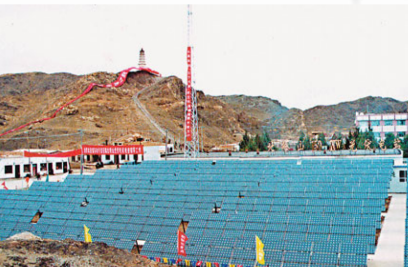
■新疆建成的當時全國最大單機容量為150KW的太陽能光伏電站
