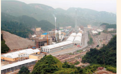
開陽大水工業園磷煤化工基地120萬噸磷酸二銨項目，項目總投資28億元，是目前國內唯一的坑口大型高濃度磷肥裝置。 姚海 攝
