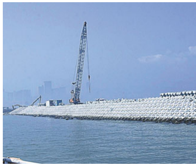
港珠澳大橋珠澳口岸人工島護岸的輪廓已顯現。香港文匯報記者黃殿晶攝
