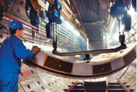
有人認為地鐵建設必須排查事故隱患，加強施工人員的安全培訓和防護，完善管理和監管。資料圖片
