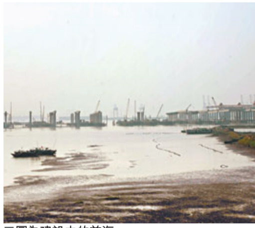
圖為建設中的前海。
