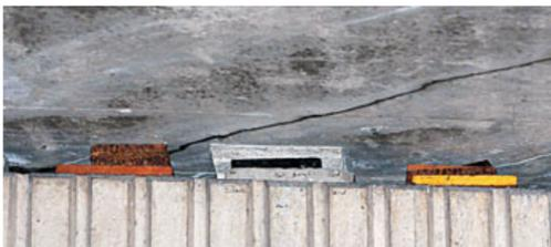
橋面「移位」導致橋臺與橋面之間的10個支座(中間)外層出現變形及裂紋,路政署已派員加裝9組臨時墊片(兩旁)。
