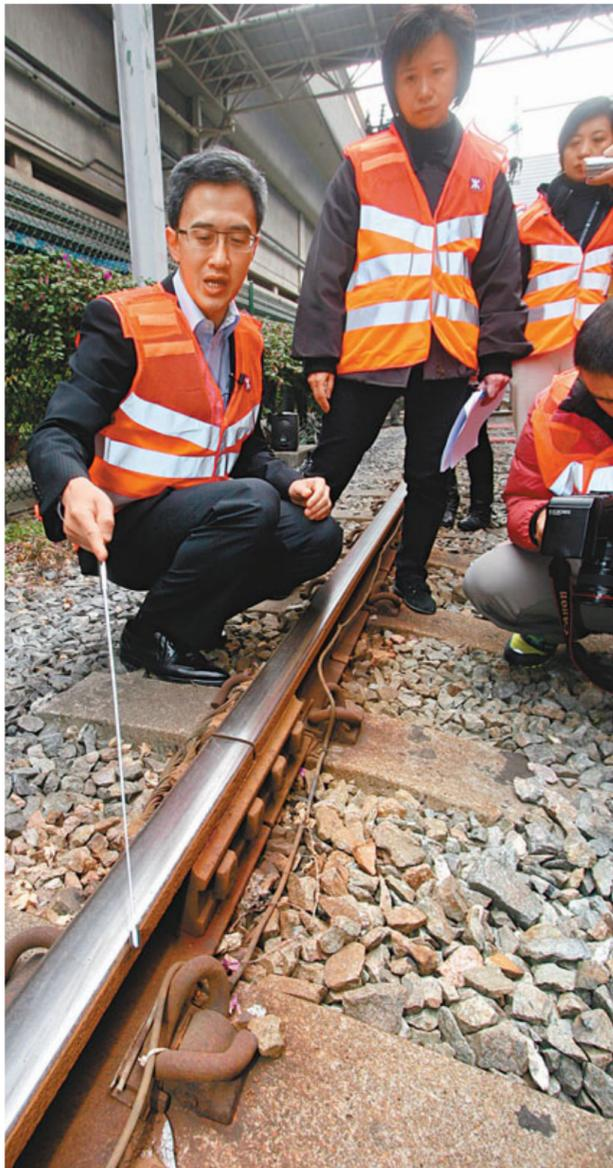
港鐵車務工程總管張少華表示，上周四出現事故的路軌裂縫，闊度僅1毫米，「只有牙籤般幼」。
