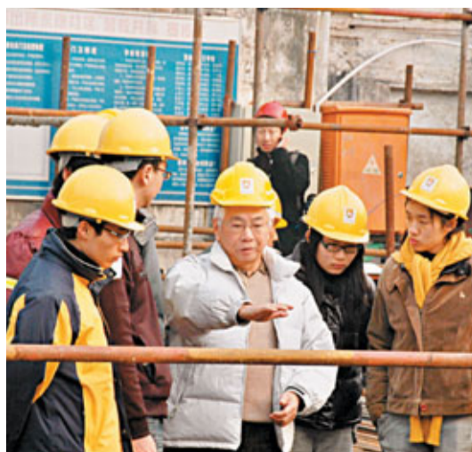
■港大師生到幼兒園倒塌現場視察情況。
