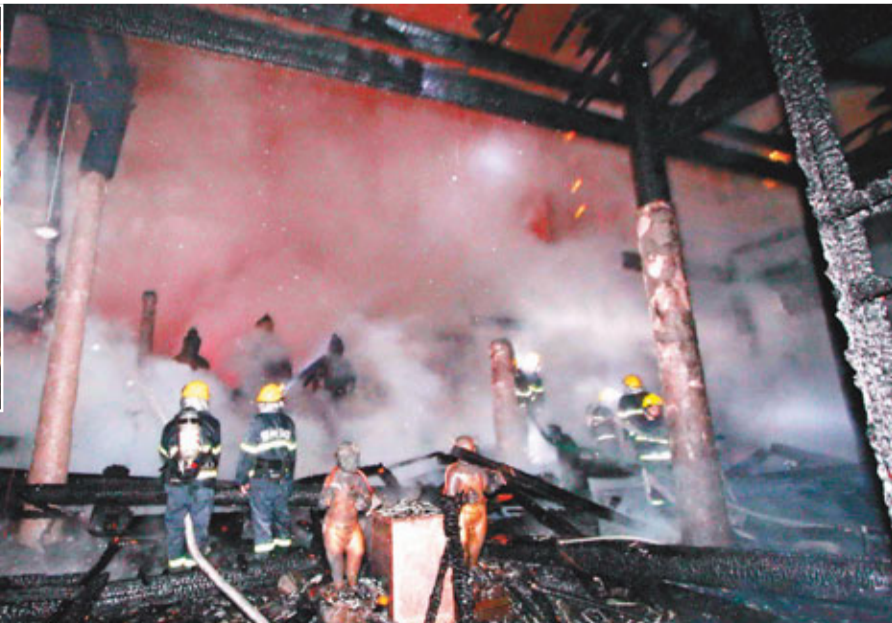
7日凌晨3時，福州千年古寺法海寺發生火災，屋頂被大火燒至塌陷。
