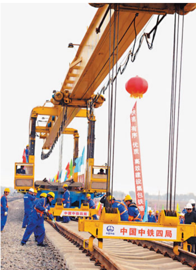
圖為「十一五」規劃中「八縱八橫」鐵路網重要工程之一的內蒙古進京「能源新通道」去年10月鋪軌。
