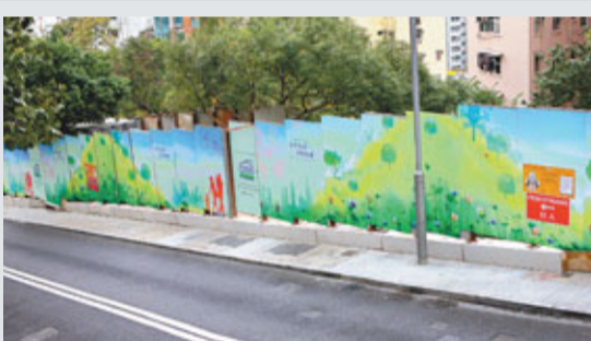
■西環蒲飛路的斜坡工地圍板，已於上月中加入美化圖案。 相片由土木工程拓展署提供
