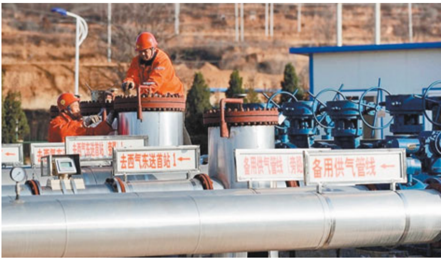
近年煤炭大省山西加快煤層氣綜合開發利用的進程。圖為工人在維護輸氣管道。
