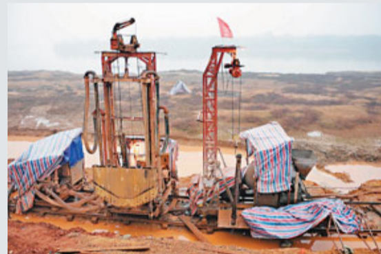
臨近農曆新年,江西撫州唱凱大堤仍在緊張施工,抓緊冬季寶貴的時間進行水利設施修建。(新華社)
