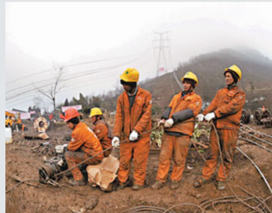
四川省電力公司施工人員在搶修受損線纜。(新華社)
