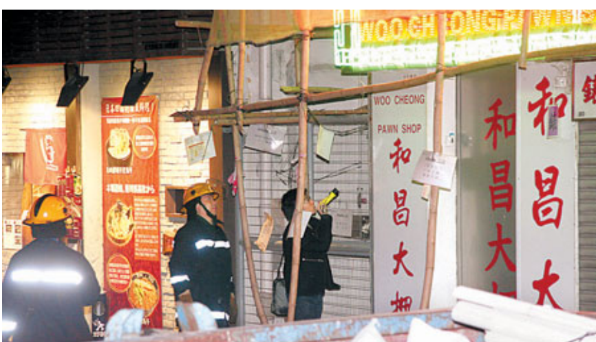
屋宇署人員在消防員陪同下檢查大廈外牆結構。香港文匯報記者鄺福強攝
