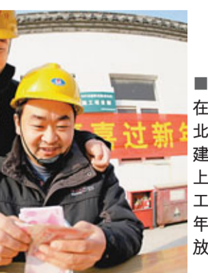
25日,在安徽省淮北供電公司建設工地上,外來務工人員領取年前提前發放的工資。
