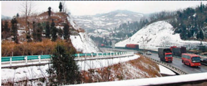
■貴州高速公路出現覆雪和凍雨,車輛緩行。香港文匯報貴州傳真
