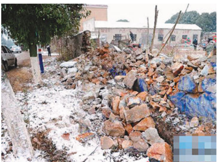
位於震中的安慶市楊梅鎮一處圍牆被震垮。
