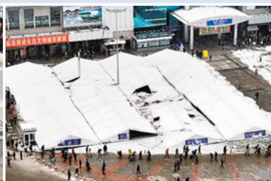
19日的大雪壓塌了貴陽火車站進站驗票大棚。
