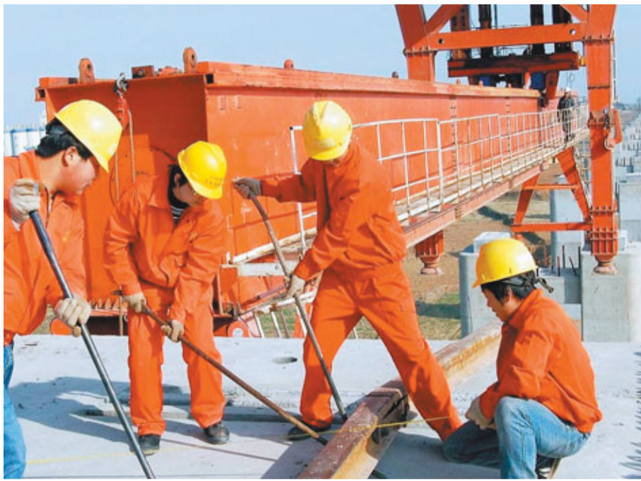
中鐵建競標美國加州高鐵如成功,將會令中國高鐵技術第一次進入美國。圖為中鐵三局職工奮戰在京滬高鐵建設工地上。
