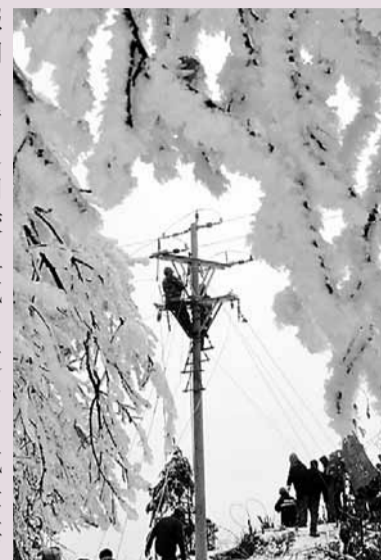
17日,四川古蔺縣「抗冰保電搶險隊」在搶修出現覆冰狀況的輸電線路。
