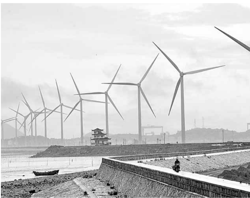
要克服能源資源瓶頸必需依靠科技革命。圖為浙江溫嶺東海塘風力發電場。
