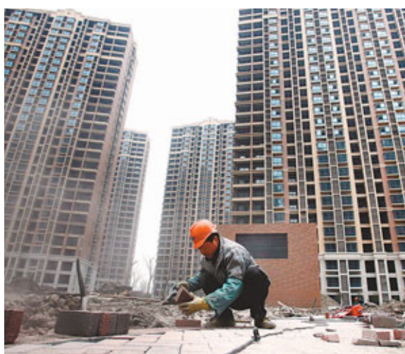
參加網上問卷調查的網友,53%尚未購房。圖為在上海首批市級統籌公租房建設工地,工人正進行施工掃尾工作。新華社
