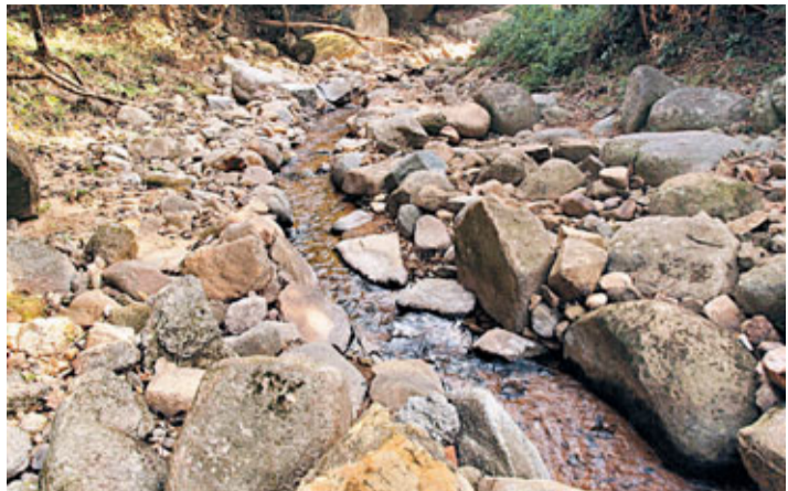
■深水灣谷原本1米闊的河面被堵至剩下半米闊。 饒戈提供
