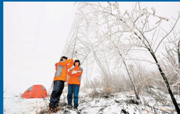
■湖南省電網建設公司的「巡線工」，每天不間斷地對線路實施覆冰觀測。
