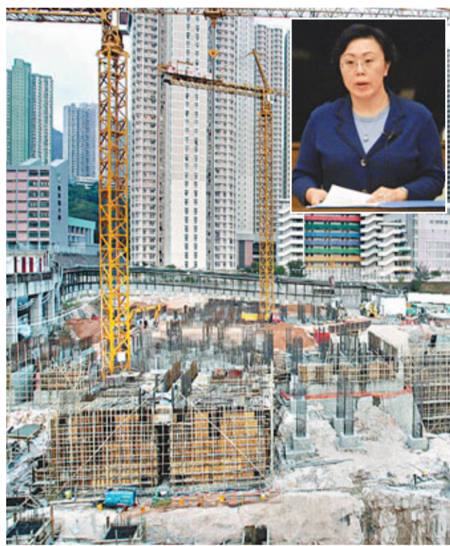
■鄭汝樺(小圖)表示, 本港未來5年新建公屋單位約有7.5萬個。圖為油塘公屋建築地盤。 資料圖片
