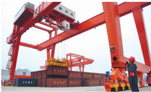
宜賓港志誠作業區一期工程提前了一年完成,在上月29日投入試運。圖為工程師正在指揮貨物運輸。
