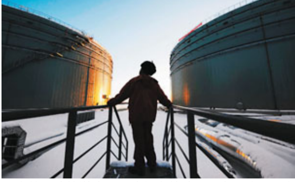
■中俄原油管道昨日正式投產輸油。圖為一名工人在漢河輸油站罐區進行巡檢。 新華社
